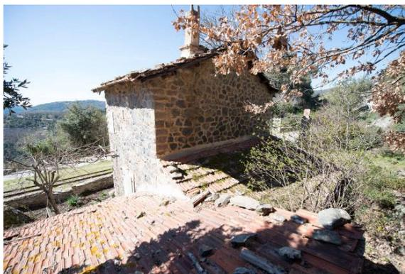
Presenta una tipologia di casello ferroviario standard. Esso si sviluppa su due piani con il piano terra costituito da un vano unico dotato di forno e della scala che conduce al piano primo, anch'esso costituito da una sala unica.
