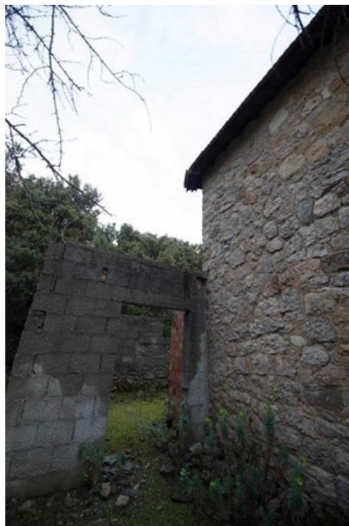
Nel corso del tempo sono state aggiunte delle pertinenze che costituivano locali di servizio che, come si vede dalle immagini, presentano caratteri costruttivi assai difforni dalla primigenia architettura del casello
