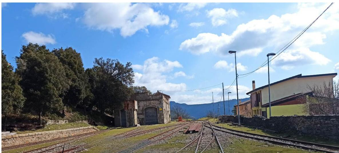
Il locale locomotive si sviluppa al solo piano terra e ha accesso esclusivamente dall'area di passaggio delle rotaie. Si presenta come un corpo di fabbrica di sviluppo rettangolare caratterizzato dalla presenza di due grandi accessi da dove transitavano le locomotive.
