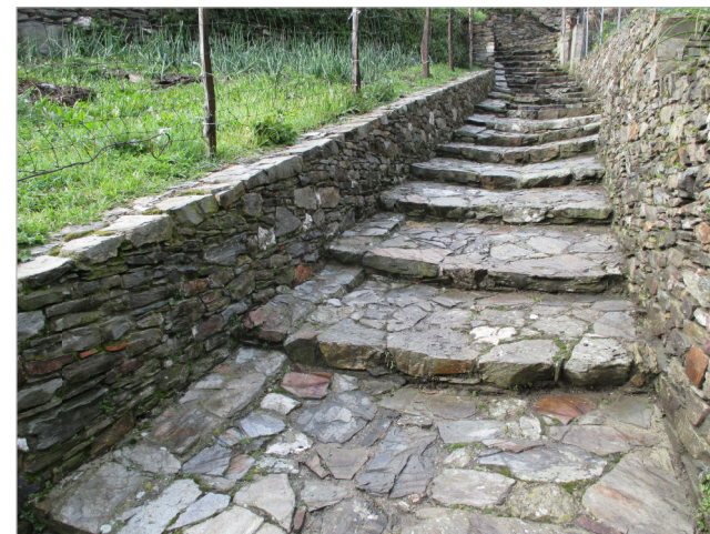
D8.3 Esempio di lastricato realizzato con conci di scisto misto a qualche trovante di porfido rosso. L'uso è sconsigliato nel centro storico se non nelle zone periferiche poco trafficate come in questo caso.
