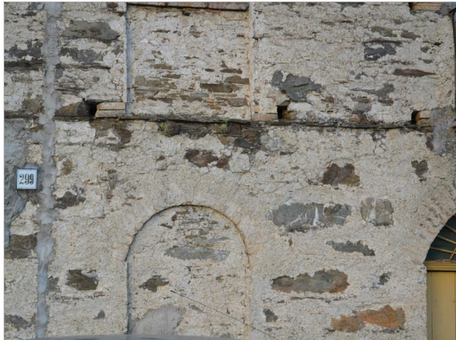
D2.4 Muratura in trovanti di scisto di varie dimensioni apparecchiati secondo corsi occasionali con malta di calce, e con strato di rinzafo a vista
