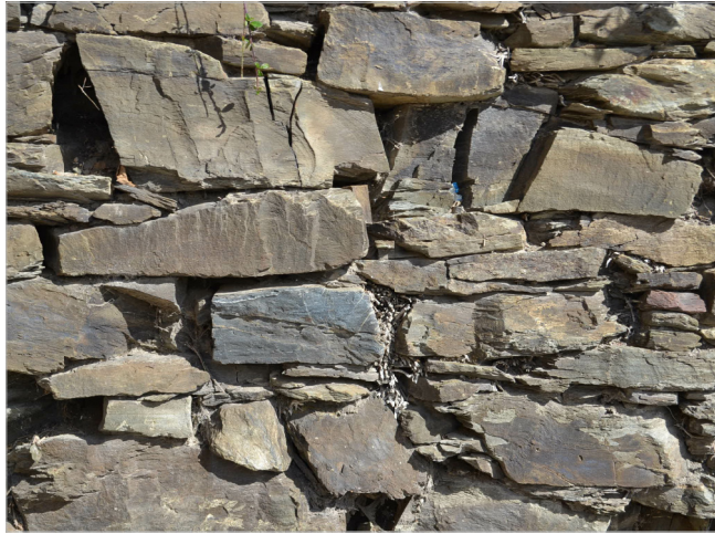
D2.3 Muratura in trovanti di scisto di varie dimensioni apparecchiati secondo corsi occasionali con malta di terra
