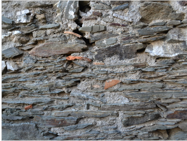
D2.2 Muratura in trovanti di scisto di varie dimensioni apparecchiati secondo corsi occasionali con malta di terra
