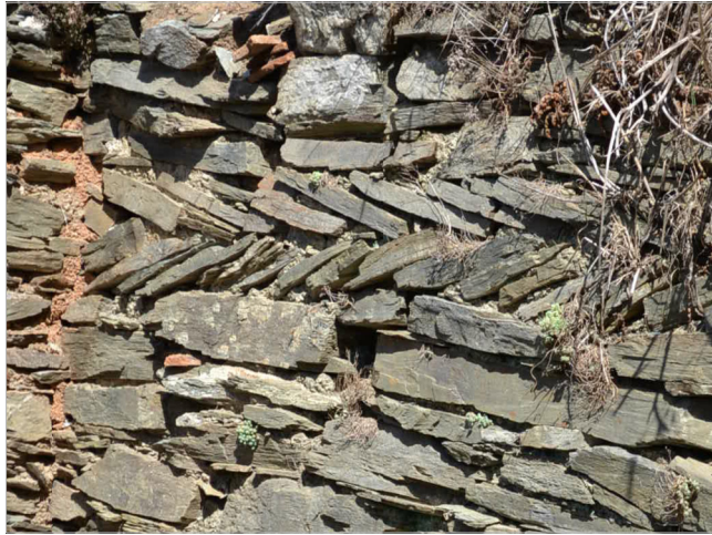
D2.1 Muratura in trovanti di scisto disposti a spina di pesce
