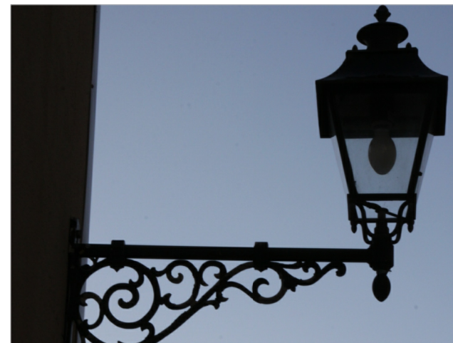
D9.3 Lampione stradale semplice, ancorato alla muratura con mensola in ghisa decorata. Di nuova concezione per l'uso nel centro matrice.
